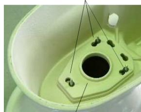
ベースを取り外したあとのシリコンシーラントは、キレイに取り除いてから再度同じところにシリコンシーラントを塗ってトラップを取り付けてください。シリコンシーラントの塊が残っていると漏水の原因となります。
